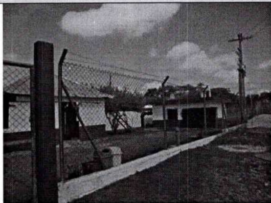
Descripción Registro Fotográfico: Estacion de Rebombeo
